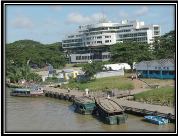
Photo 3 : Vue panoramique d'une partie du front lagunaire Nord du quartier Cité Fonctionnaire avec un bel édifice (direction de SDV-SAGA) qui côtoie la gare lagunaire centrale ; une gare artisanale dépourvue de toute esthétique et d'équipement sécuritaire. Cela malgré la présence d'un poste de police maritime dont la cour sert de passage d'accès à ladite gare.
